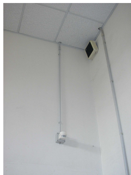
fig. 5: Dispositivo rilevatore ad infrarossi a montaggio ultimato in un'aula.
