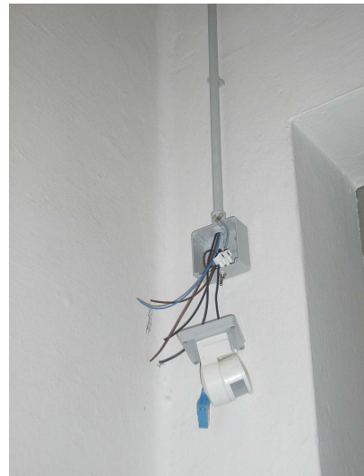
Fig. 3: Dispositivo rilevatore ad infrarossi durante la fase del montaggio.
